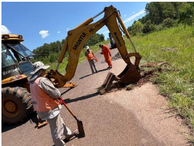
Figura 10 y 11: Destape y extracción de base granular estabilizada. Calicata N°2.
