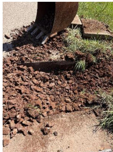
Figura 10 y 11: Destape y extracción de base granular estabilizada. Calicata N°2.
